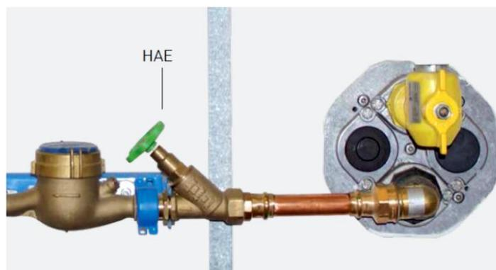
Generell dienen Absperreinrichtungen dazu, die Wasserzufuhr im Falle eines Schadens oder bei kurzfristigen Arbeiten an der Trinkwasser-Installation zu unterbrechen. Die HAE sitzt in der Regel dort, wo die Wasserleitung durch die Wand ins Haus kommt. Manchmal kann sie sich auch in einem Wasserzählerschacht außerhalb des Gebäudes befinden. In diesem Fall sollten Sie Ihren Installateur mit der Überprüfung beauftragen. Steigen Sie zu Ihrer eigenen Sicherheit nicht selbst in den Schacht.
